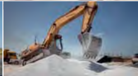
152 KM Hidraulinis ekskavatorius perveža skaldą į vietą.
