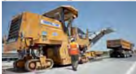
142 KM Dirba PM200 asfaltbetonio klotuvus
